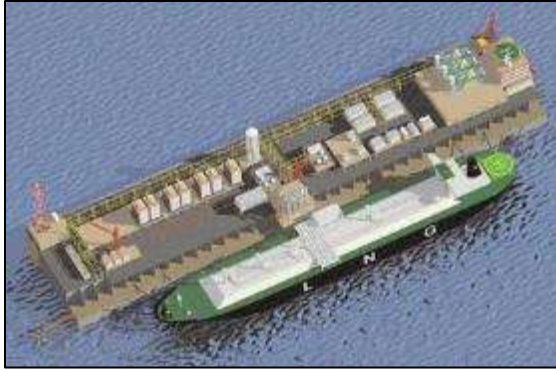
Floating LNG Terminal, Argentina
